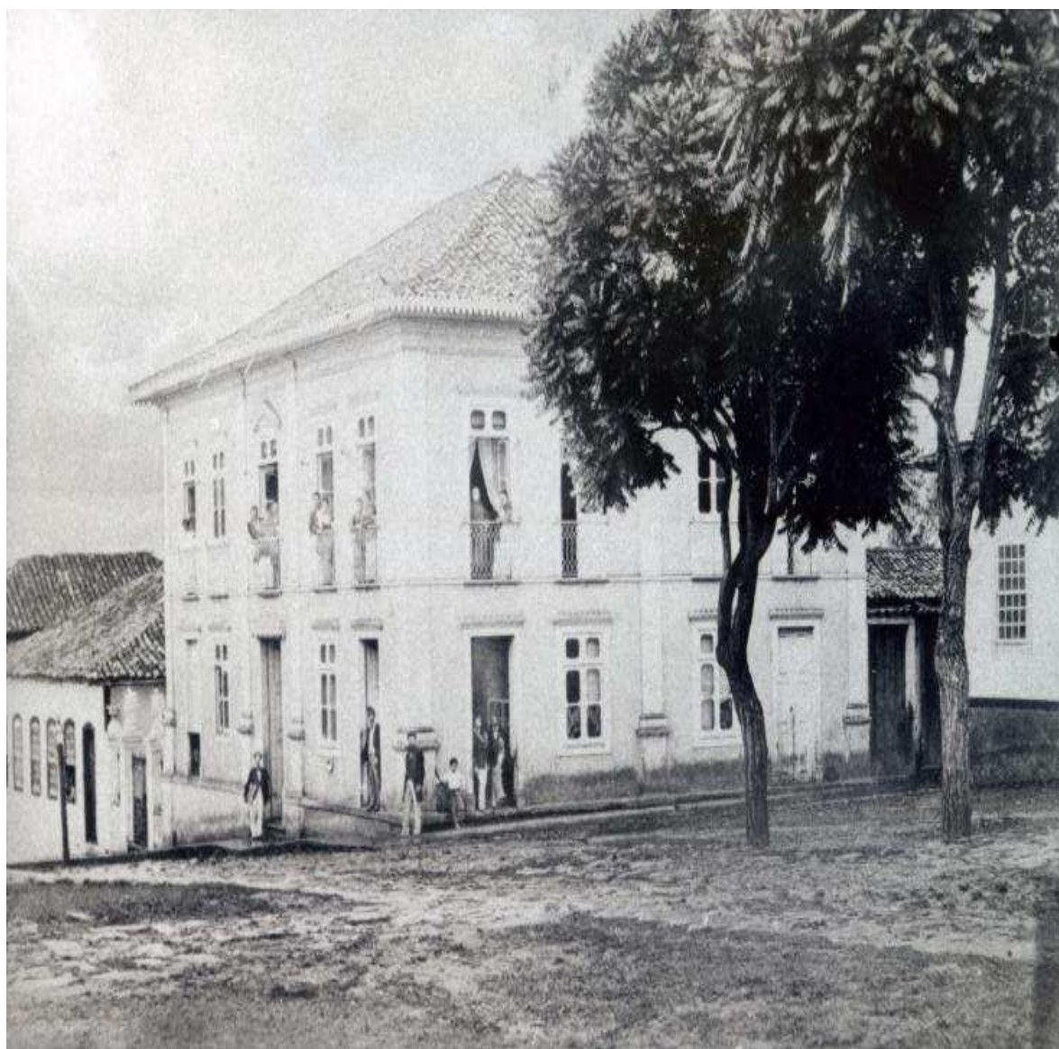
FIGURA 15 – Residência de Bernardo Saturnino da Veiga, em Campanha, no século XIX. No térreo, funcionou a livraria e, posteriormente, a redação do Monitor Sul-Mineiro .
