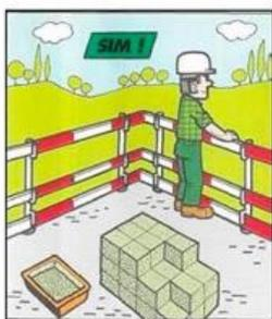
Os dispositivos destinados a impedir as quedas devem estar sempre instalados e em bom estado de conservação.
