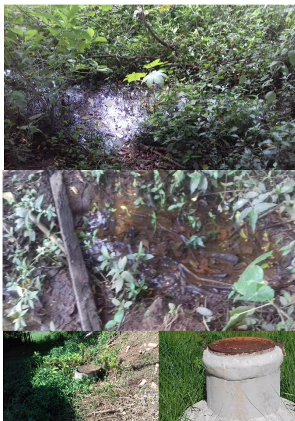
Figura 3 - Água da nascente empoçada e poços de inspeção de esgoto
