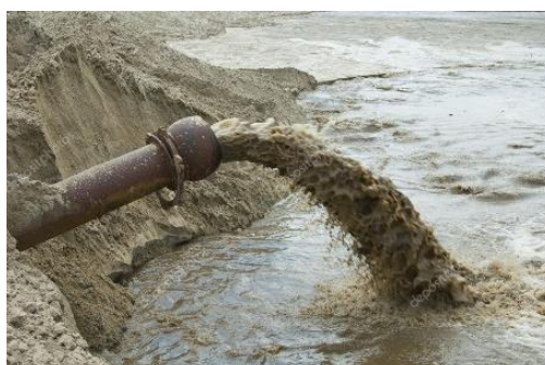
Imagem18: Fluxo de água suja em tubulação
