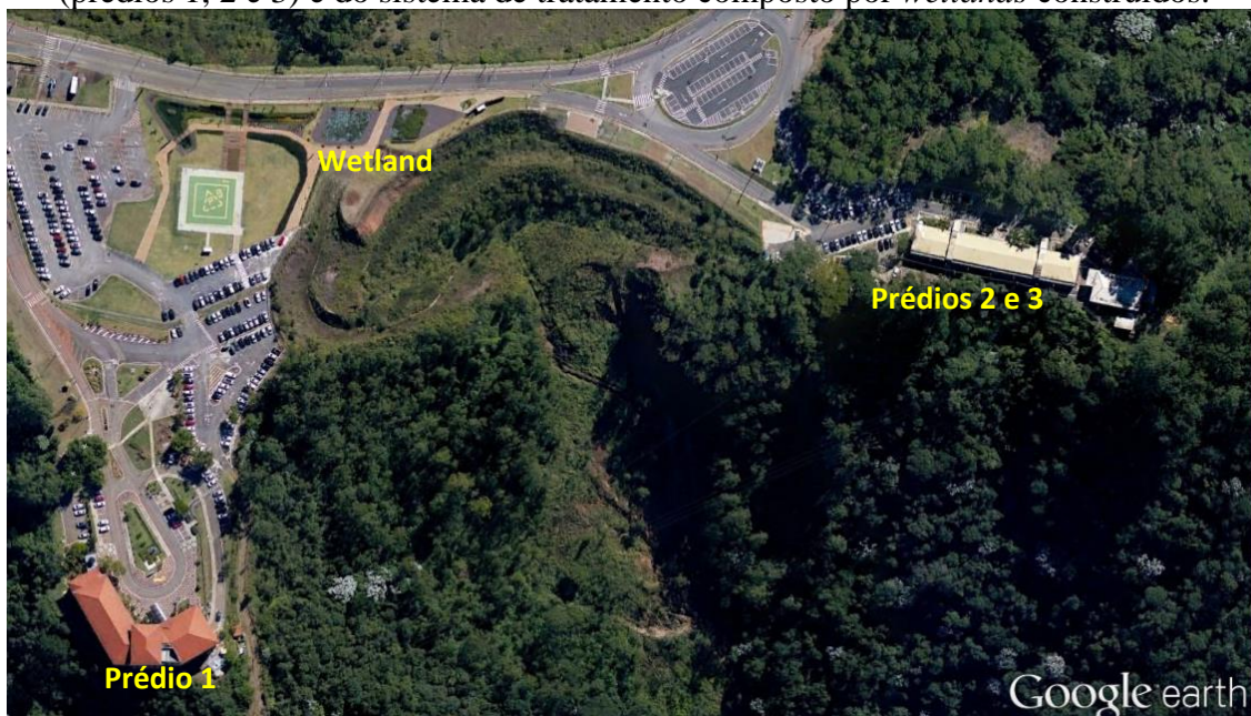
Figura 6 – Localização e identificação das fontes geradoras de efluente sanitário (prédios 1, 2 e 3) e do sistema de tratamento composto por wetlands construídos.
